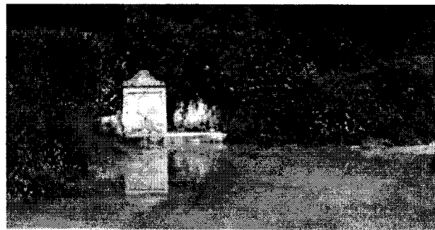
Nella foto lo stato di degrado in cui versa l'antica e storica quanto preziosa fontana ubicata in contrada "Gurneda".
